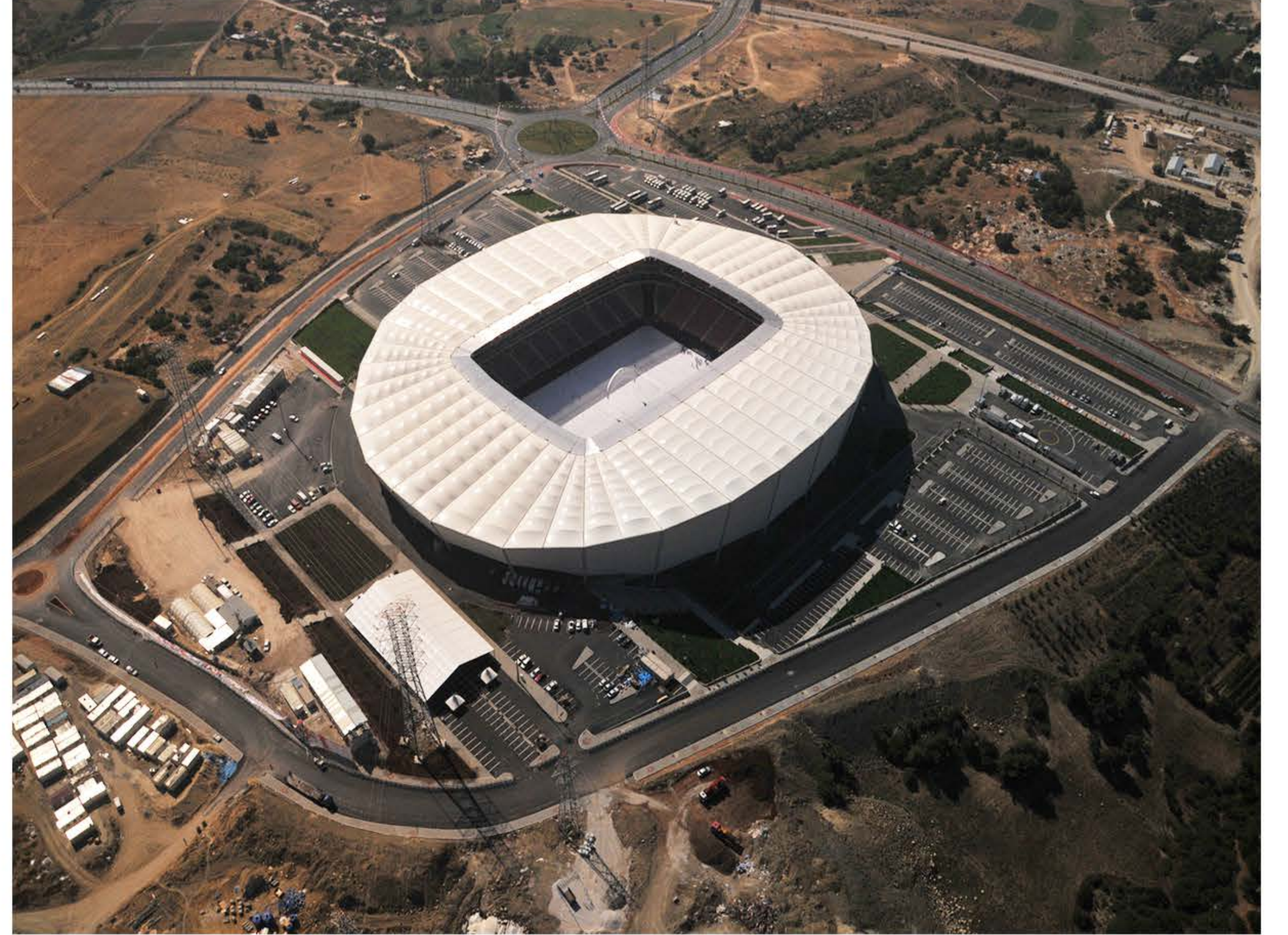
MERSİN ARENA STADYUMU ' Merdiven ve dış mekanlarda kullanılan BAZALT taşı, DEVTAŞ tarafından temin edilmiştir.
