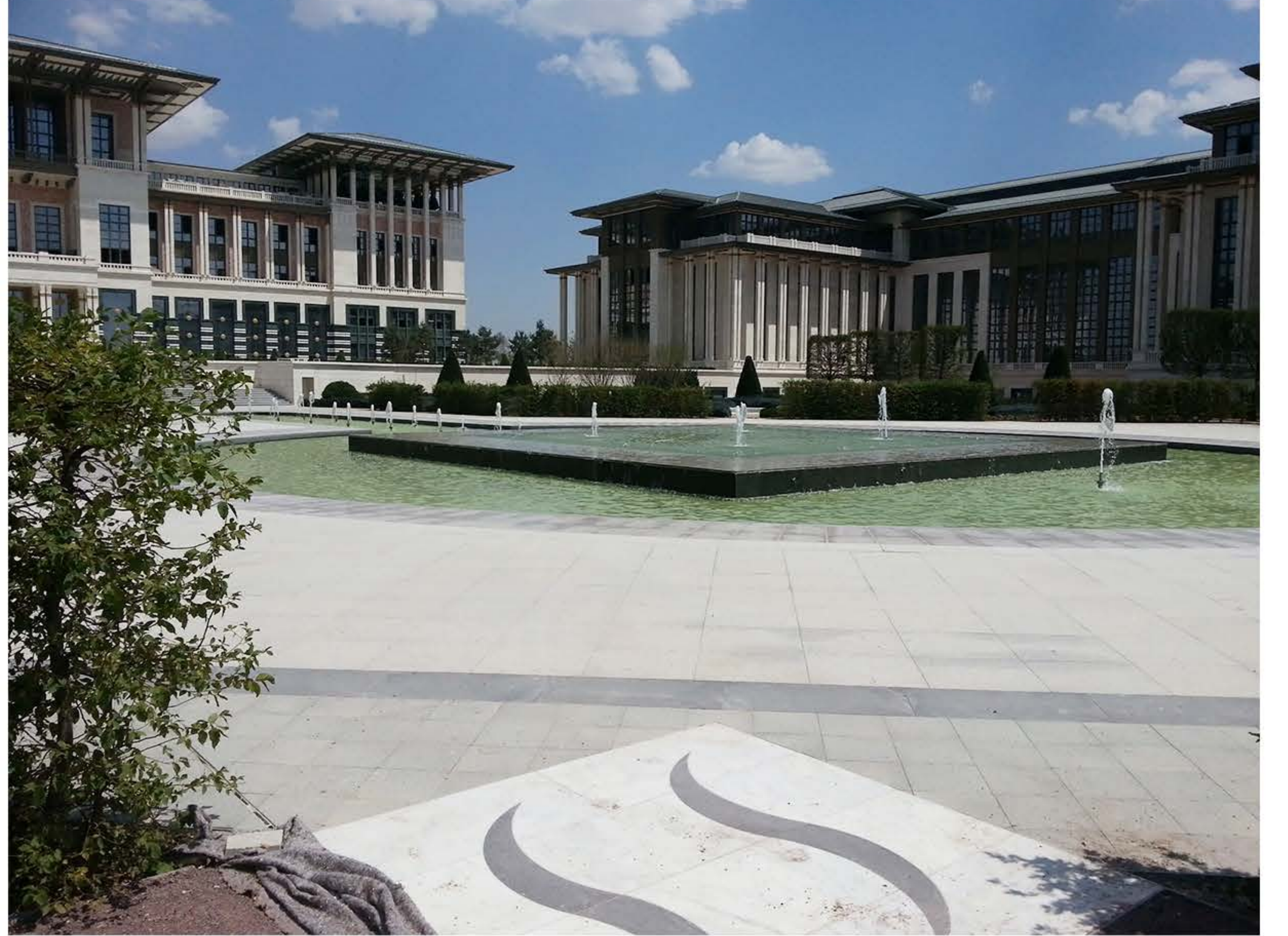
T.C. CUMHURBAŞKANLIĞI SARAYI inşaatı yapımında, Bazalt ve Diyabaz taş teminini ve uygulamasını yapmıştır.
